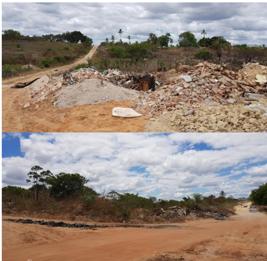
Figura 40: Baixa da Santinha - descarte irregular de RCC. Fonte: Felco Faleiros - fev/19.
