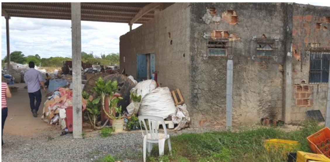
Figura 18: Precariedade do barracão.
