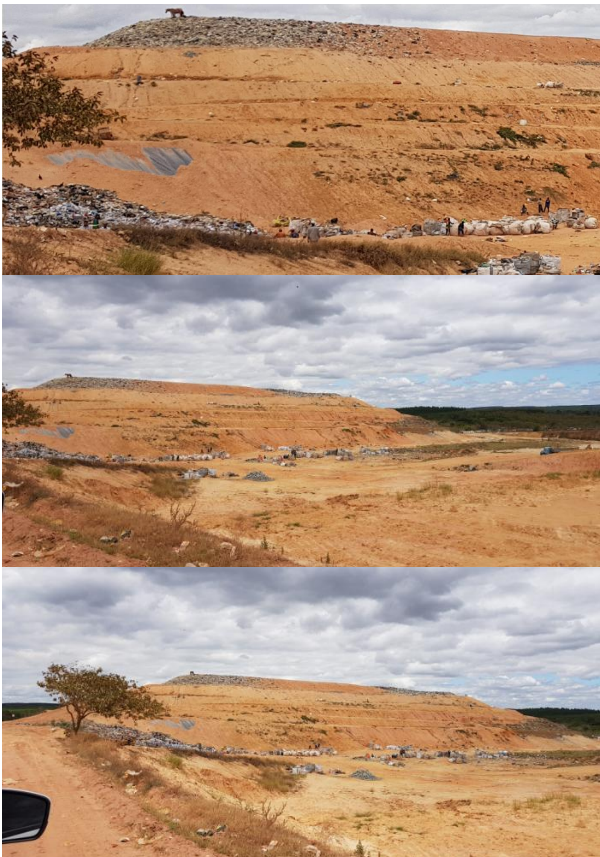
Figura 32: Vista do aterro municipal - fev/19. Fonte: Felco Faleiros.
